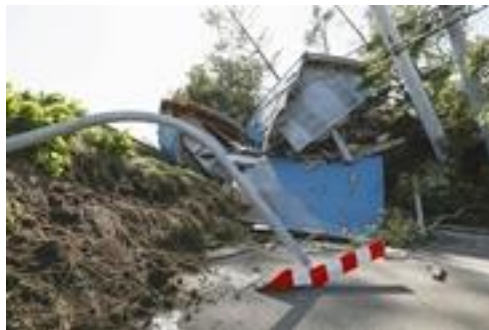
大規模な土砂崩れで倒壊し、道路をふさぐ建物＝ 中日新聞より
