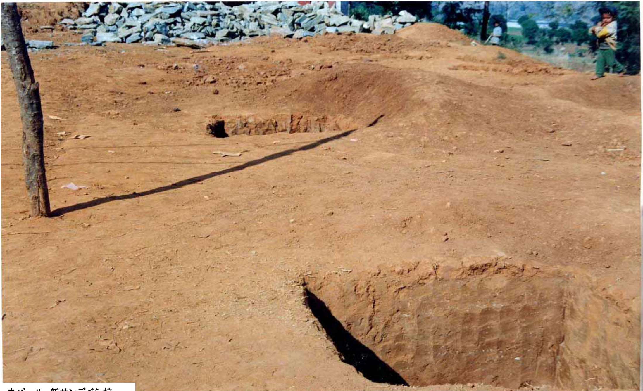
ネパール 新サンデベシ校 建設基礎工事
