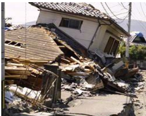
地震で倒壊した住宅。 熊本県益城町宮園・徳島新聞
